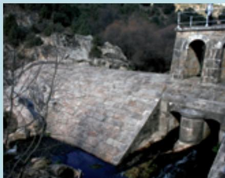
El Azud del Mesto, hoy en desuso, fue construido en el año 1906 utilizando una presa preexistente. Tiene 4 m de altura y está construido en sillaría de piedra caliza. El agua se captaba mediante un sistema de compuertas para para conducirla hasta el Sifón de Guadalix. En Peña Águila se puede observar un antiguo canal excavado manualmente en la roca, por el que discurría el agua antes de la construcción del Canal del Mesto.
